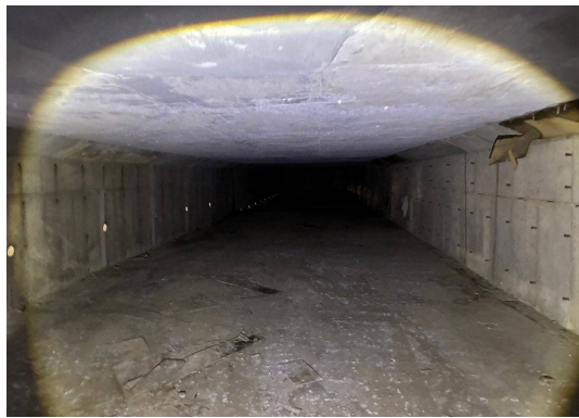
시점부 접속옹벽 BOX 내부 현황
